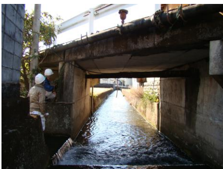
図 3.1 定期点検の様子
