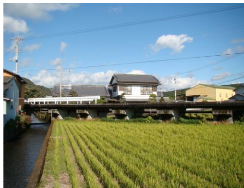
樋ノ口橋 (昭和51年架設)
