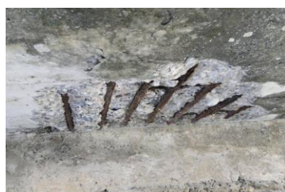
図1.3 損傷区分eの状況写真
